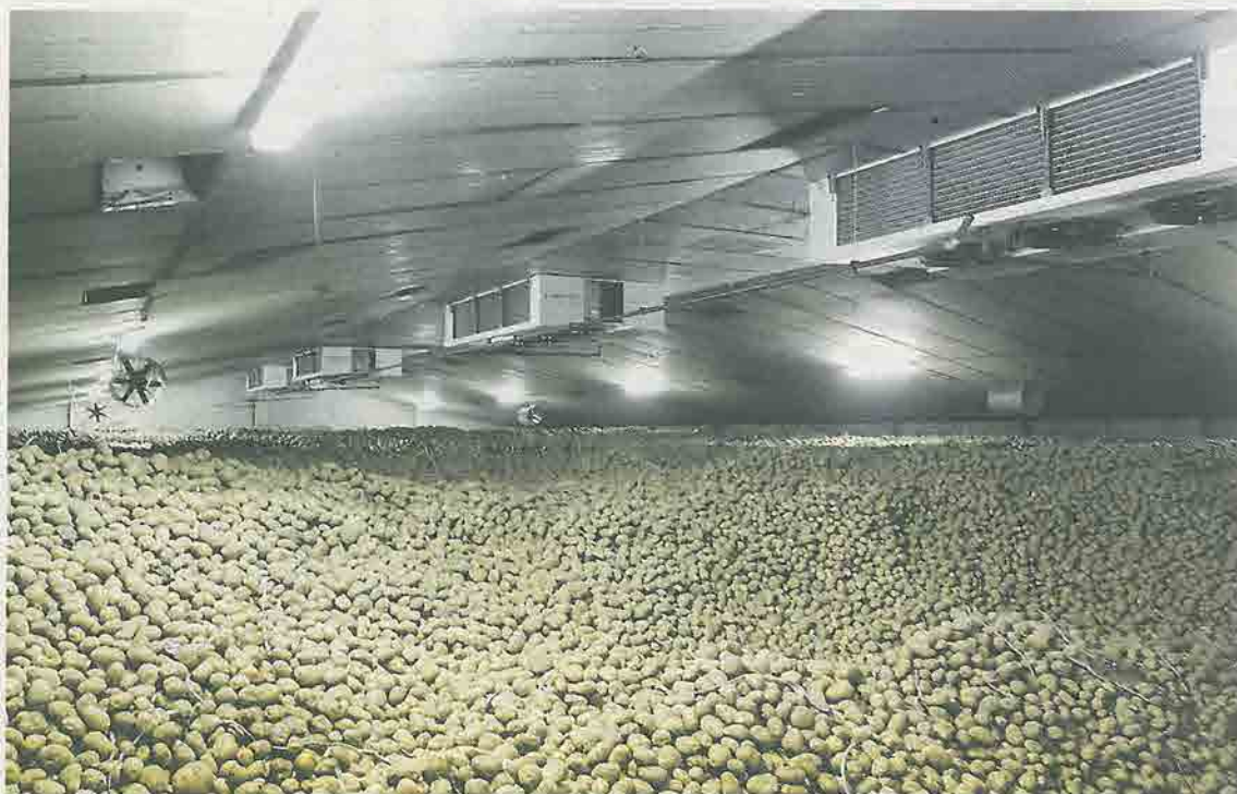
Lose Lagerung von Kartoffeln mit mechanischer Kühlung.
