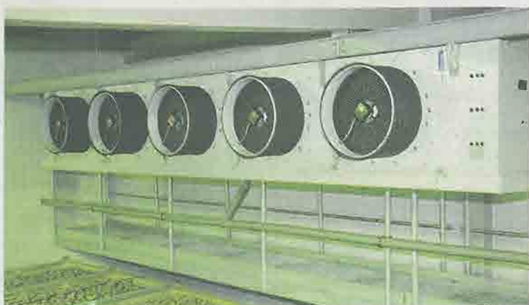
Verdampfer zur Wärmeaufnahme aus dem Lagerraum.
